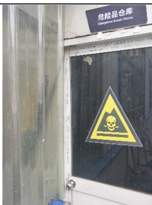
危险固废暂存库
